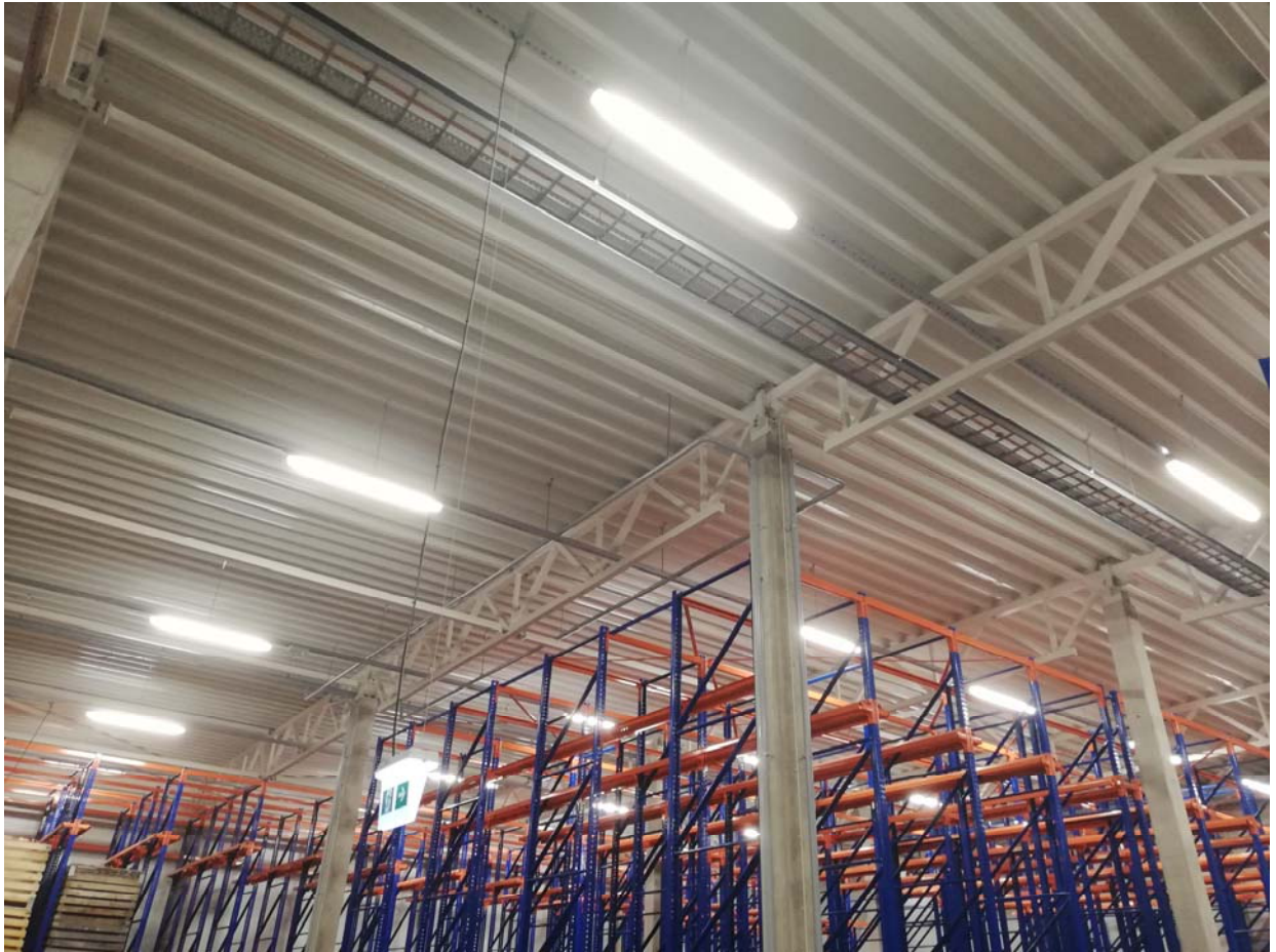
07 pav. Nagrinėjamo statinio stogo konstrukcijų fotografacija
