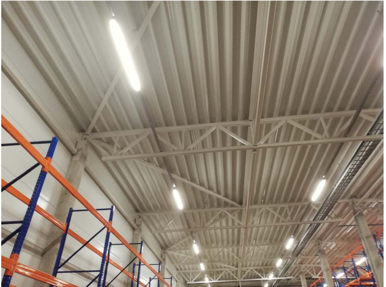
05 pav. Nagrinėjamo statinio stogo konstrukcijų fotofiksacija
