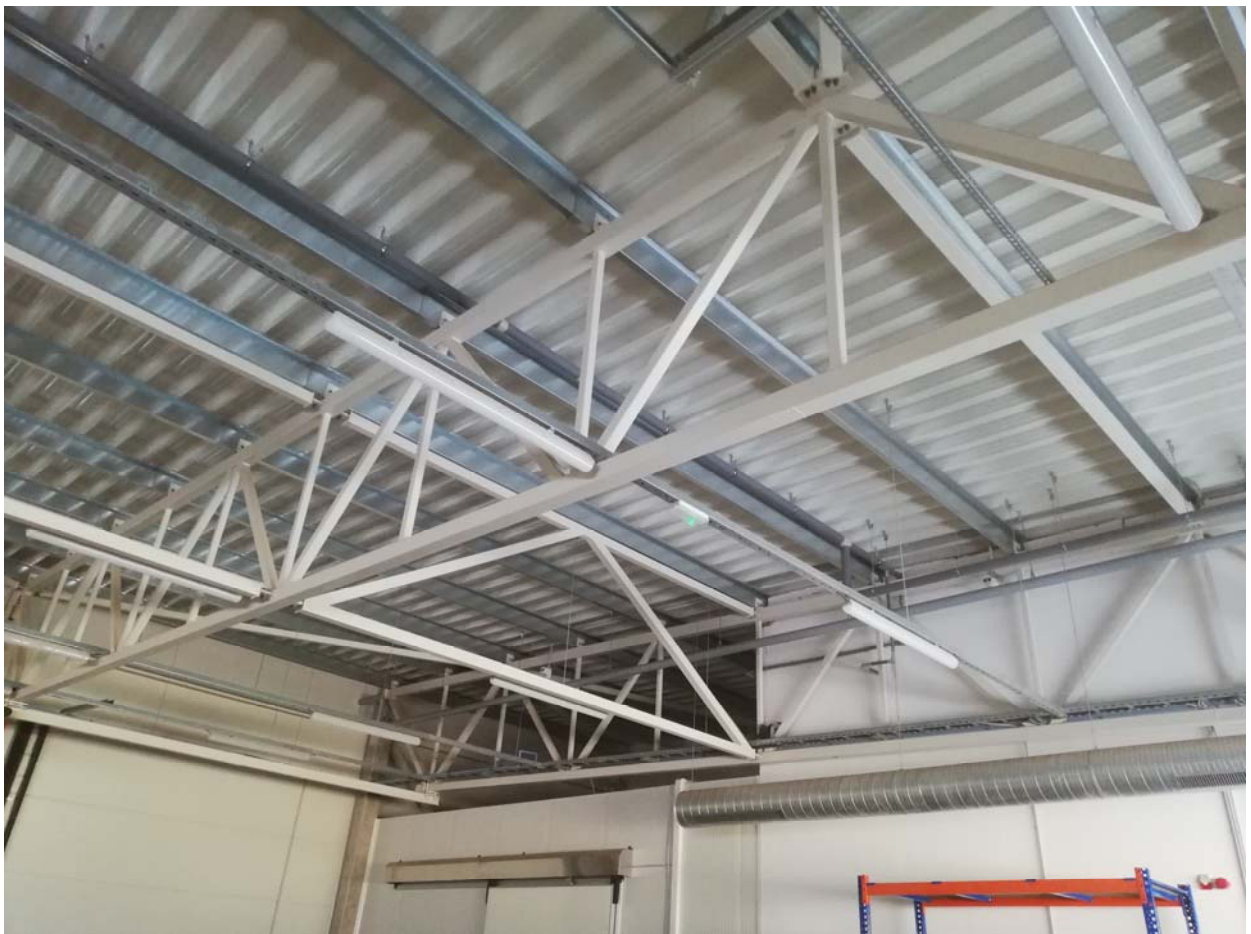
10 pav. Nagrinėjamo statinio stogo konstrukcijų fotofiksacija
