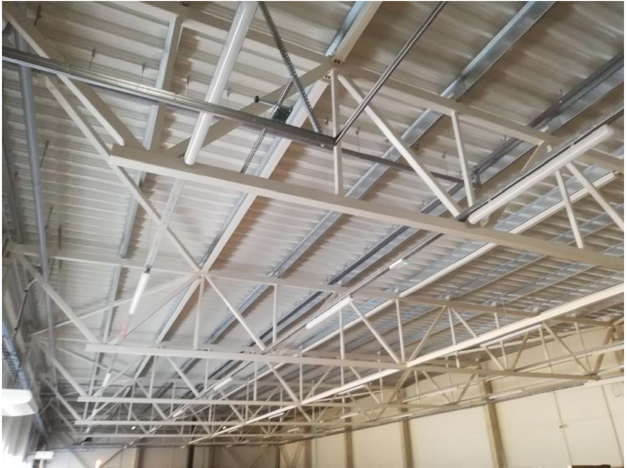
09 pav. Nagrinėjamo statinio stogo konstrukcijų fotofiksacija
